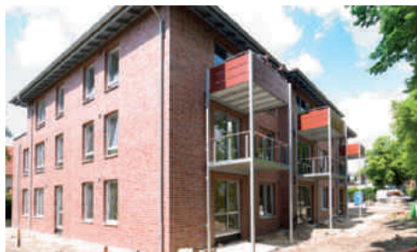
/ Der angebaute Balkon: Die Fertigung erfolgte normgerecht.
